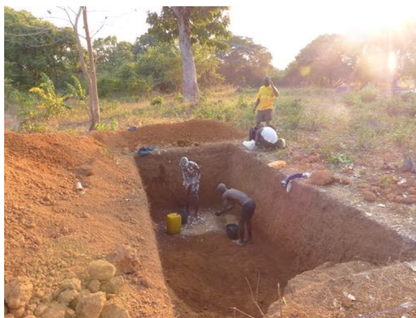
Excavation pour les fosses des latrines le 5 décembre
