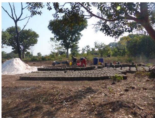
Production des agglomérés de béton le 6 décembre
