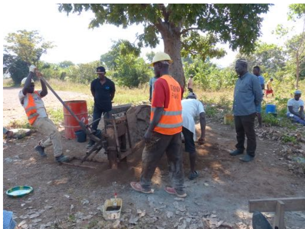
Station de production des briques d'argile BTCS
